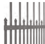
Espacement réduit par rajout de tubes débordants et pointes dans le soubassement
