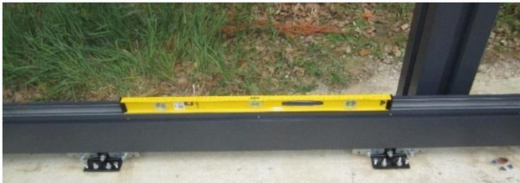
Régler le niveau en serrant les vis d'extrémités
